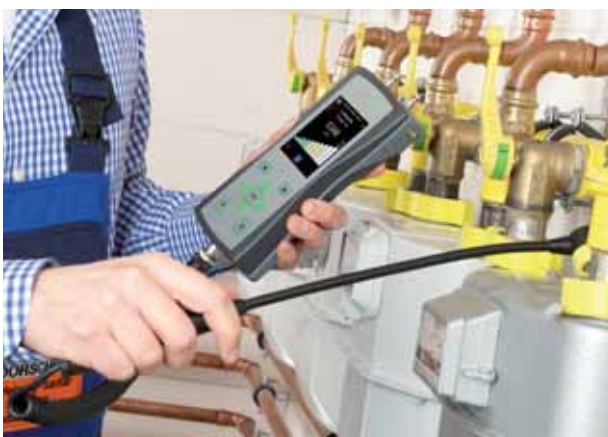
Gaslecksuche mit Erdgassensor
