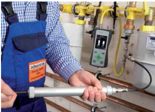
Dichtheitsprüfung 150mbar / Belastungsprüfung 1bar
